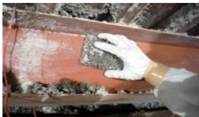
石綿除去作業 (レベル1吹付け材)
