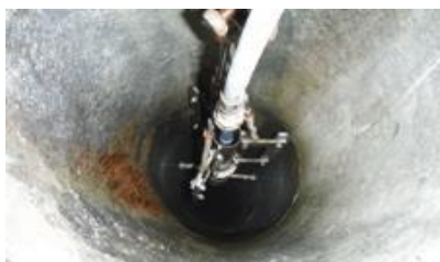
石綿除去作業 (レベル2煙突断熱材)
