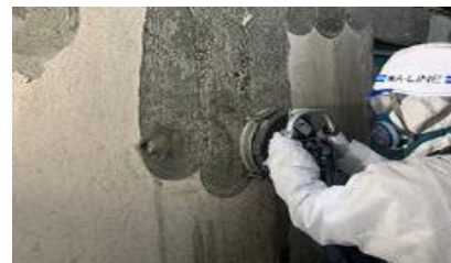
集塵装置付き超高压水洗工法 (レベル3対応工事)
