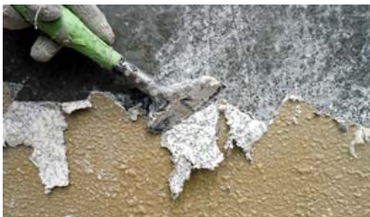
石綿除去作業 (レベル3外壁仕上塗)
