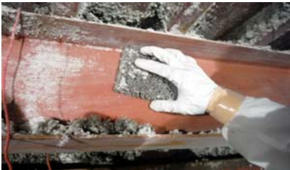
石綿除去作業 (レベル1吹付け材)
