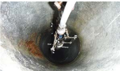
石綿除去作業
